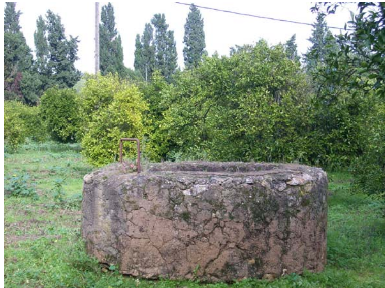
Foto 3. Chimenea de acceso a las galerías
