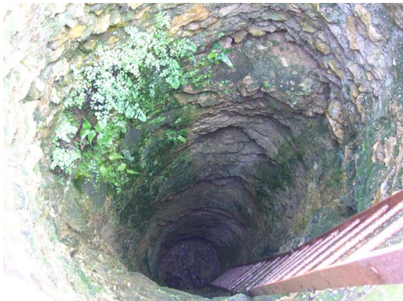
Foto 4. Interior de la chimenea y de la galería
