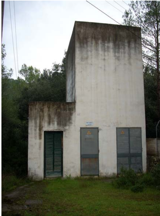
Foto 2. Pozo de abastecimiento en Crestatx
